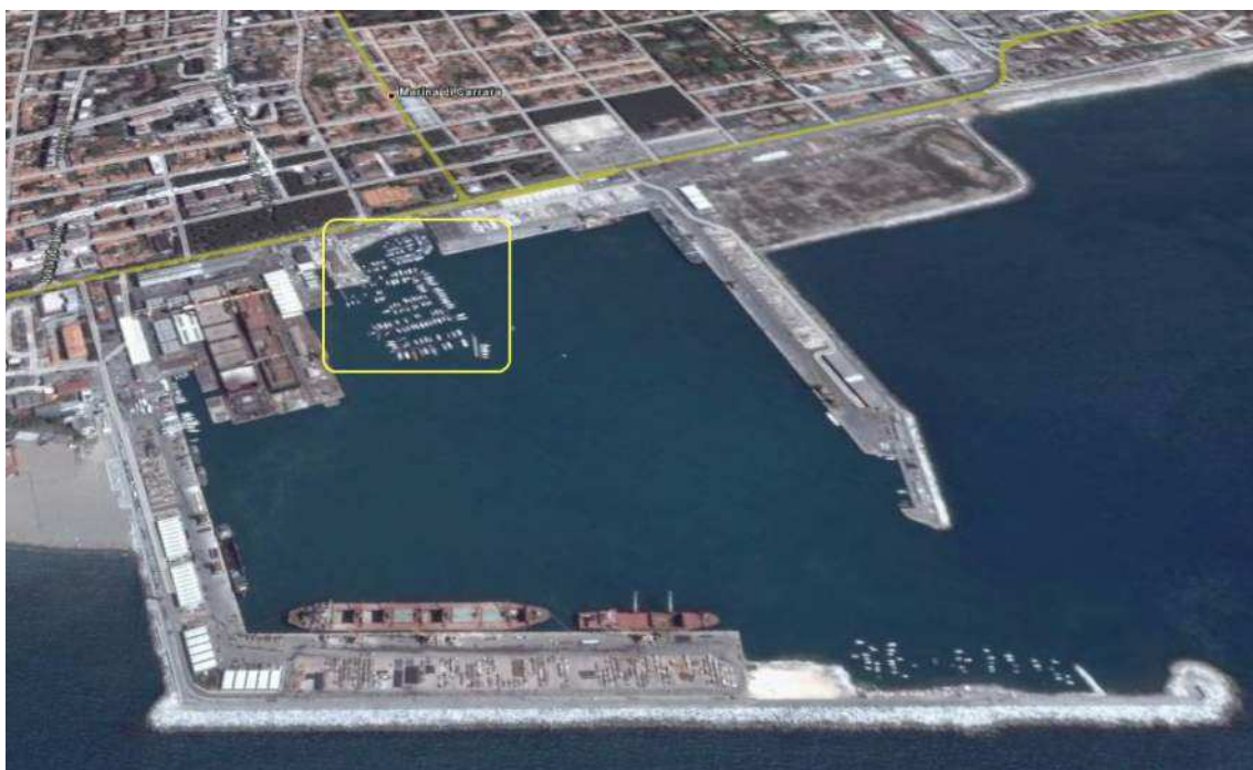
Fig. 3 - Conflittualità nello sviluppo di funzioni diverse: la “nicchia” del porto turistico, interna allo scalo commerciale e limitante l’attività dell’adiacente cantiere navale - Fonte: Google Earth
